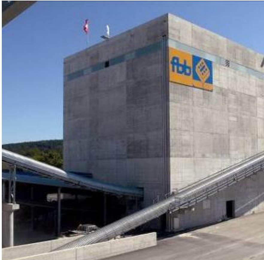
Bines de Almacenamiento -2% humedad
